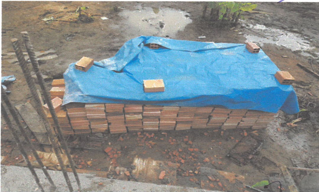
FOTO N°06: EN LA FOTO, se muestra el acopio o almacenamiento de ladrillo para la posterior construcción de los muros.
