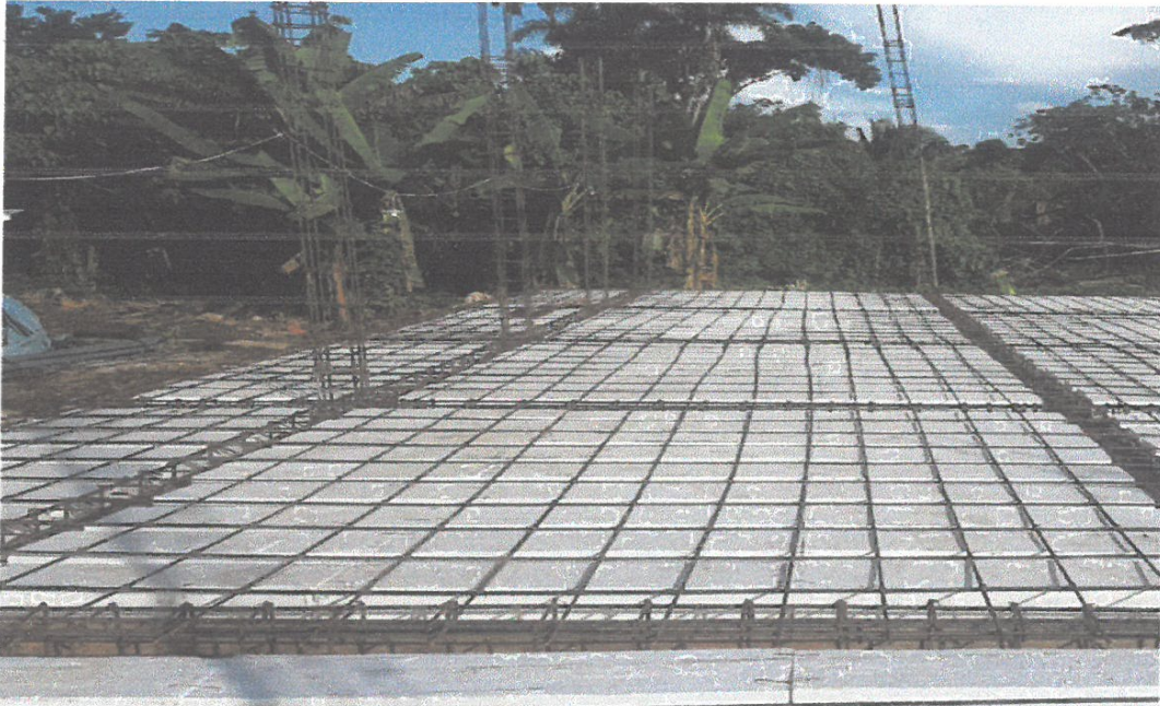
FOTO N°03: En la foto se observa la distribución de los aceros de refuerzos, las vigas de acero y el Tecnopor.
