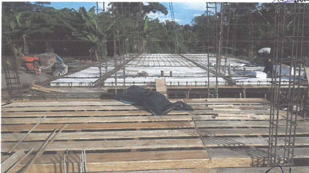
FOTO N°02: Se observa el trabajo de encofrado, colocación de Tecnopor y habilitación de acero para la losa aligerada.
