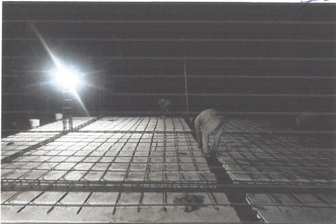
FOTO N°04: se observa los trabajos de amarre de los aceros de refuerzos.
