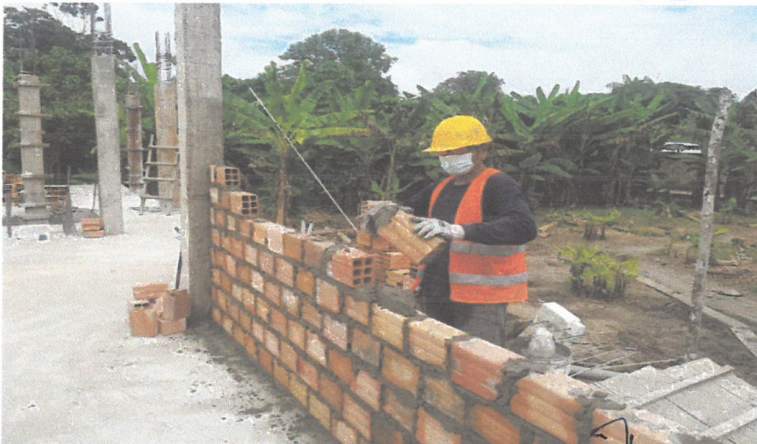
FOTO N°10: Construcción de muro.
